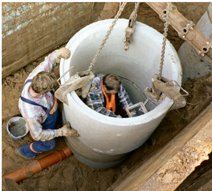
Am 22. Oktober 2007 – 11.55 Uhr wurde das letzte Rohrstück mit dem Übergabeschacht verbunden.
