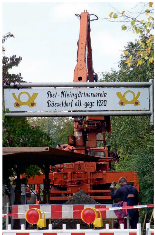
Am 3. September 2007 kamen die ersten Großgeräte – Bagger, Radlader.
