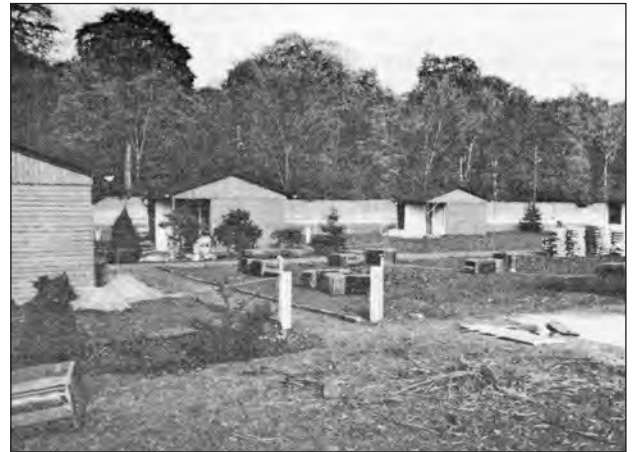
Ein neuer Anfang am Lantz'schen Park, kurz vor dem Richtfest
